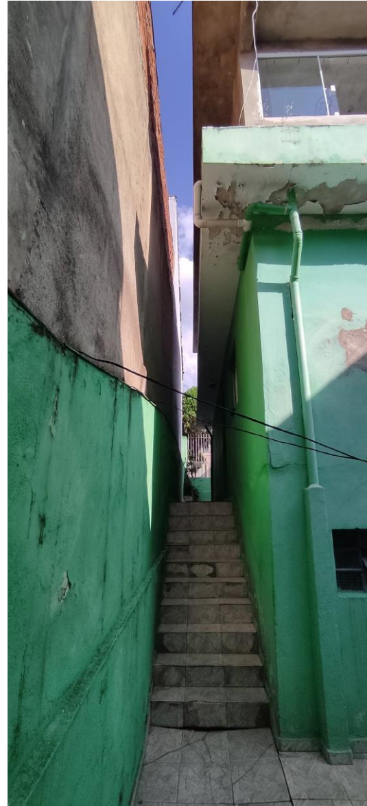
FOTO 07 : corredor de acesso ao sobrado 01. Vista dos fundos para a frente.
