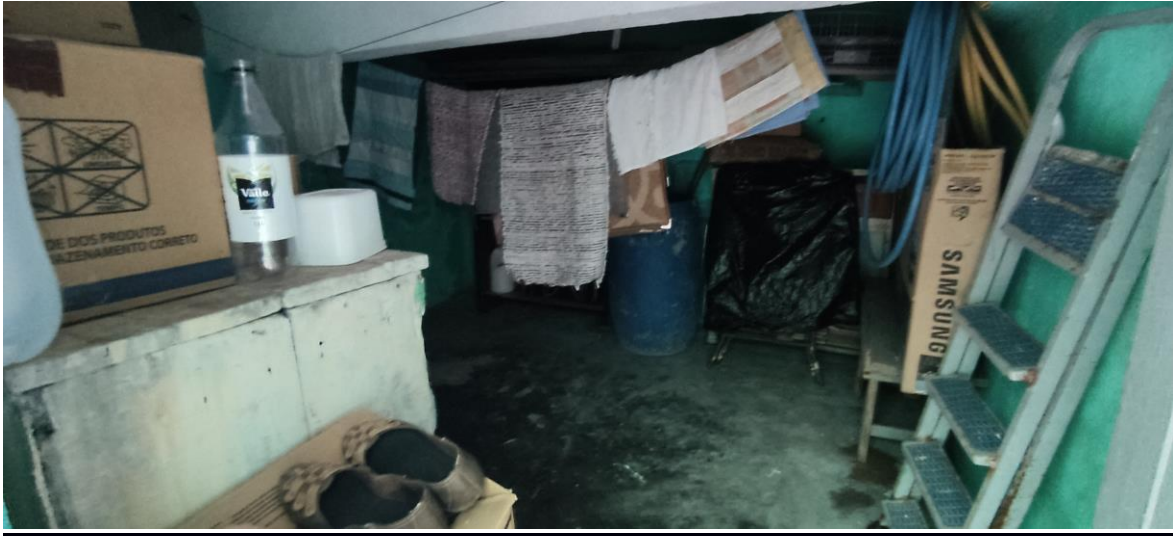
FOTO 11 : Vista interna do porão.
