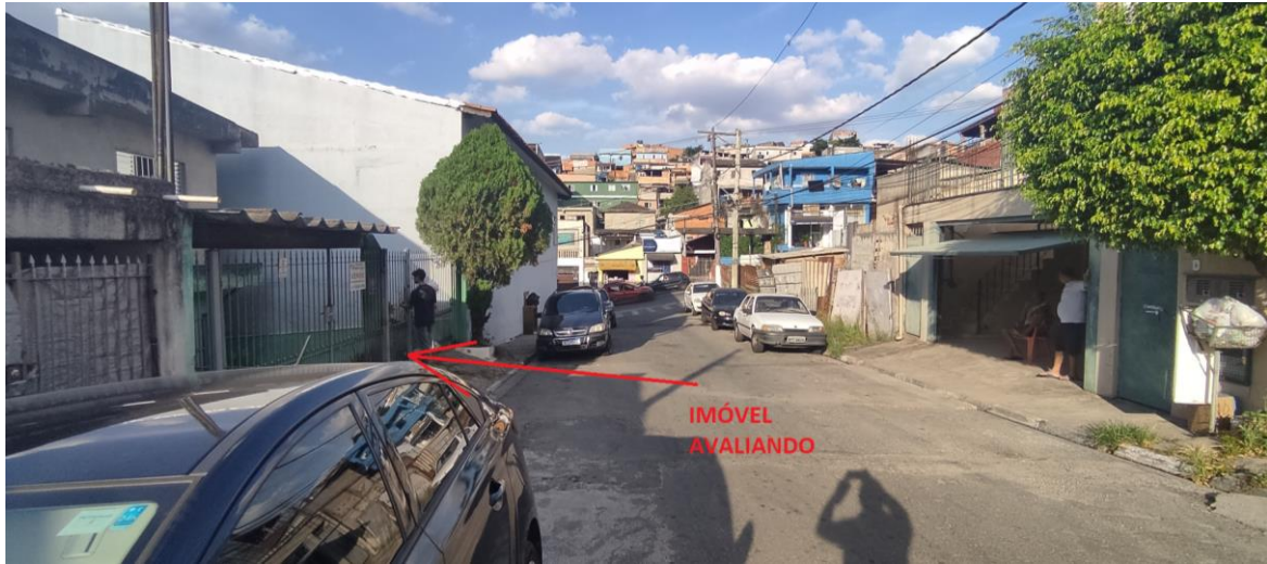
FOTO 02: Vista da Rua Tocantins, no trecho onde está situado o imóvel objeto da avaliação, à esquerda de quem da mencionada rua o observa.
