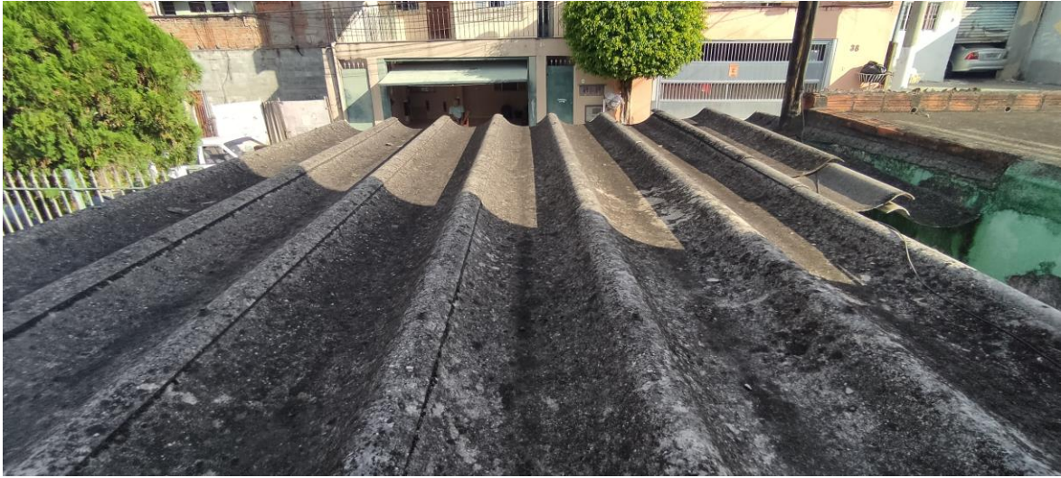
FOTO 48 : vista superior do telhado da garagem.
