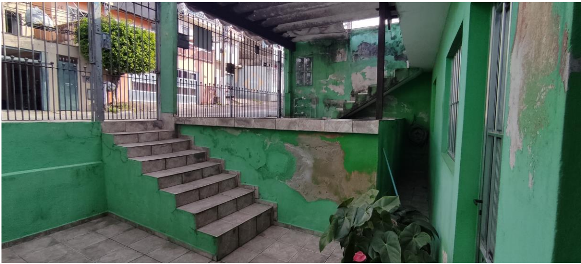
FOTO 04 : Aspecto da garagem e dos acessos.
