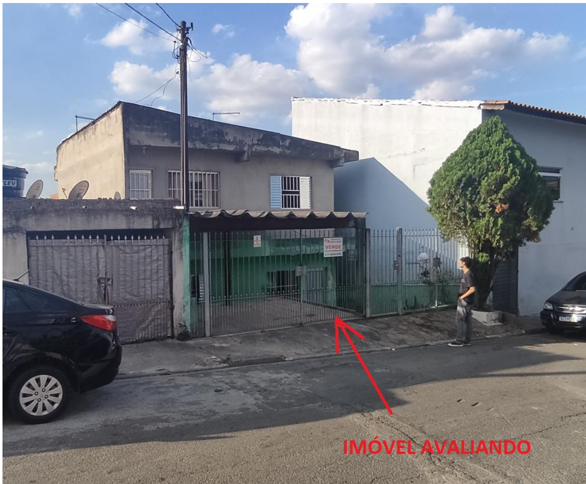
FOTO 01 : Vista frontal do imóvel avaliando.
