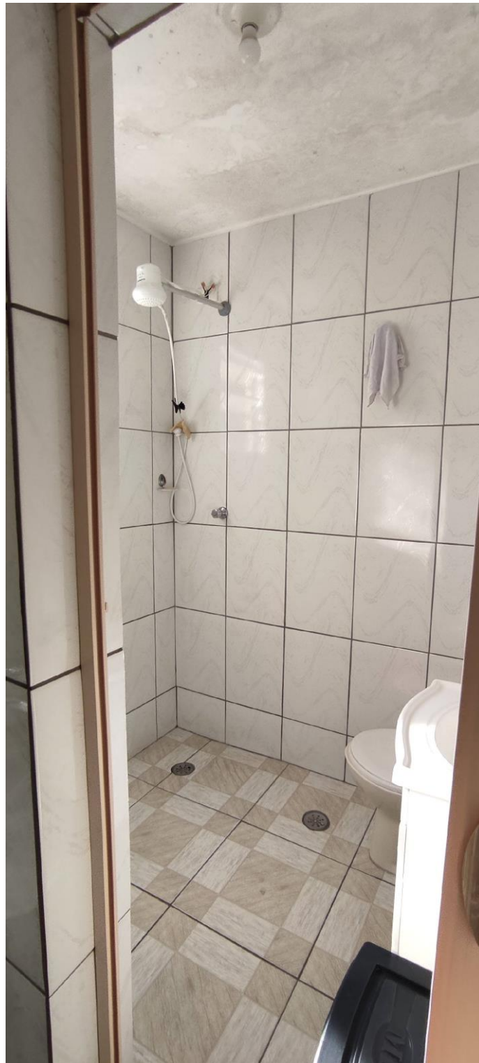
FOTO 40 : Sobrado 02 - superior: vista parcial do wc adjacente à cozinha.
