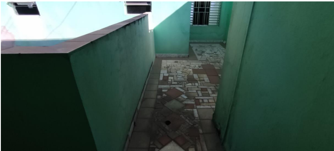
FOTO 29 : Sobrado 01 - superior: vista da varanda, e na frente, vista dos fundos do pavimento térreo do sobrado 02.
