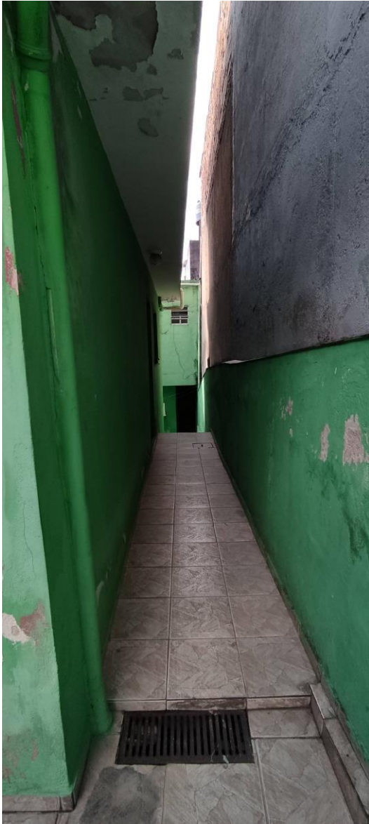
FOTO 06 : corredor de acesso ao sobrado 01. Vista da frente para os fundos.
