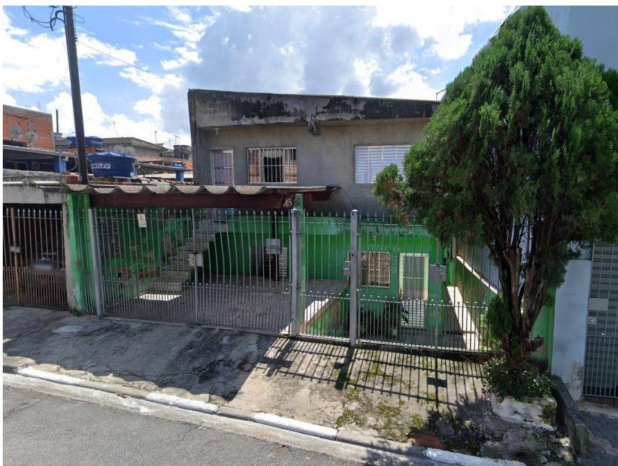
VISTA FRONTAL DO IMÓVEL AVALIANDO
