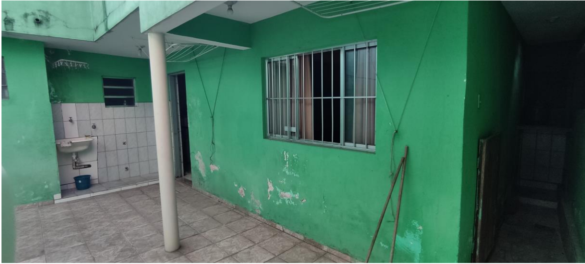
FOTO 08: Vista frontal do sobrado 01 - térreo.
