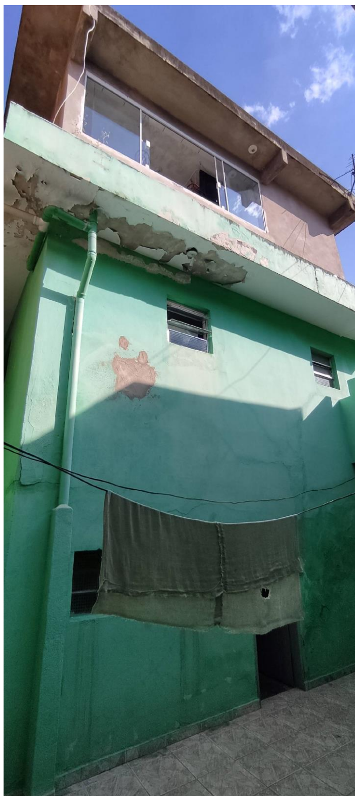
FOTO 10: Vista dos fundos do sobrado 02: porão, térreo e pavimento superior.
