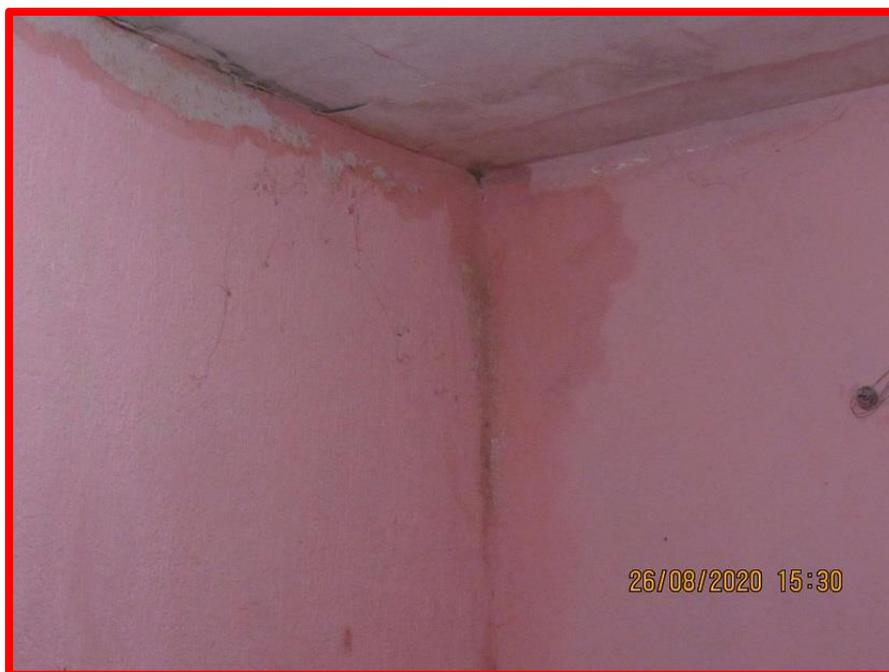
FOTO 10: Infiltração em algumas paredes.
