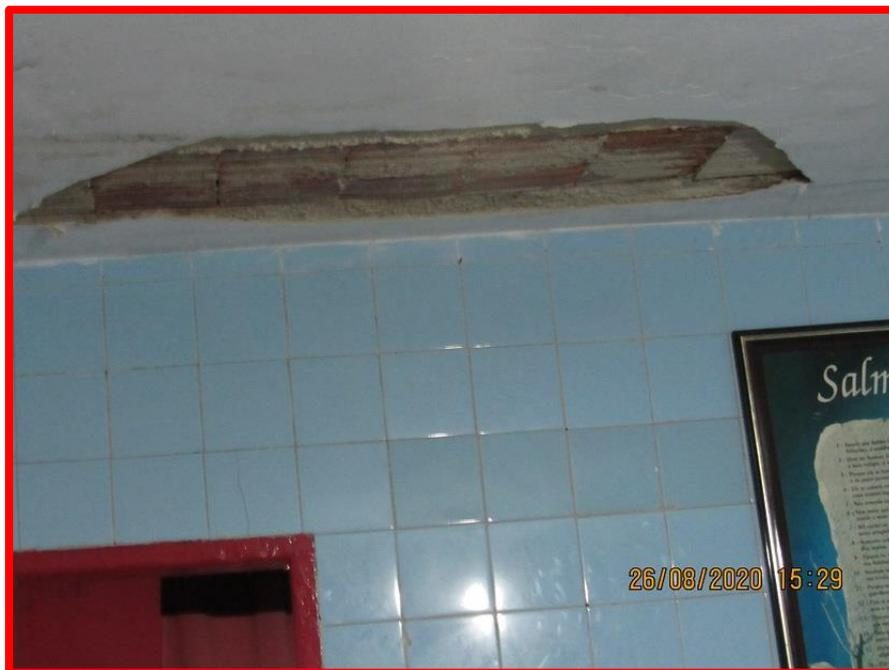
FOTO 14: Laje com deslocamento de reboco.
