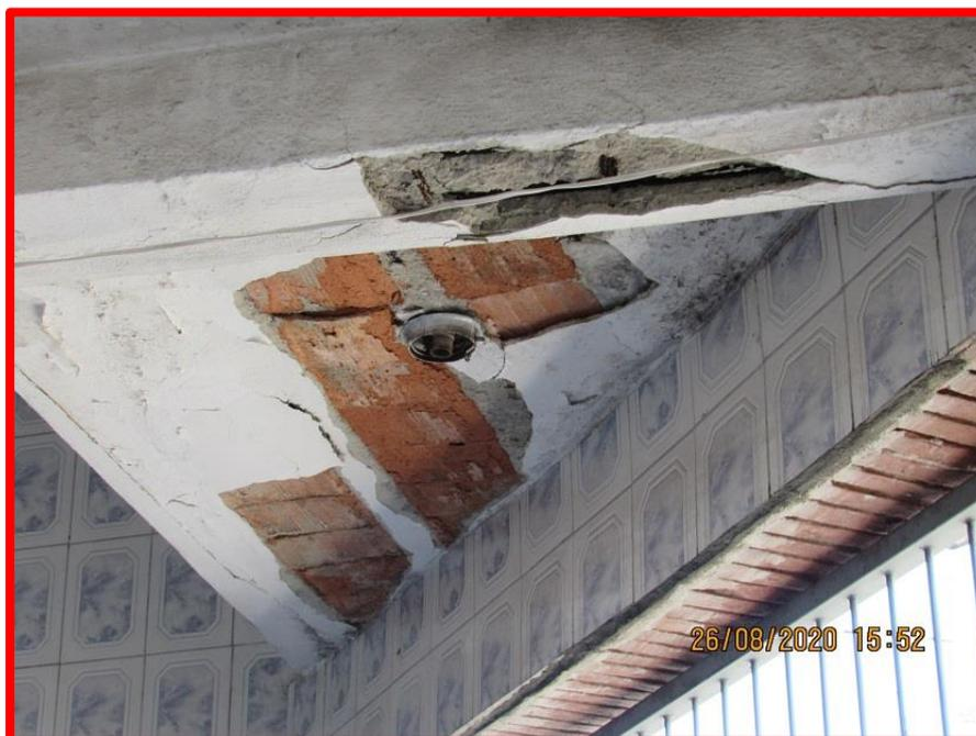
FOTO 15: Laje com armadura exposta.
