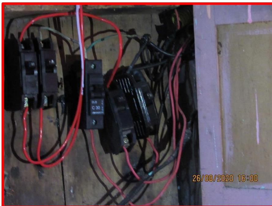
FOTO 12: Instalação elétrica em desconformidade com a Norma.
