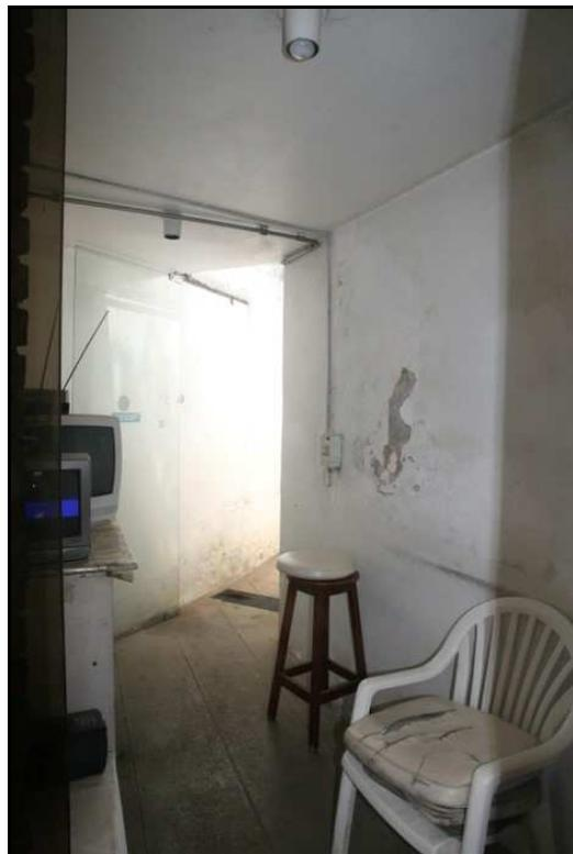
**FOTOS 10/11/12 - Guarita, com sinais de umidade nas paredes.**
