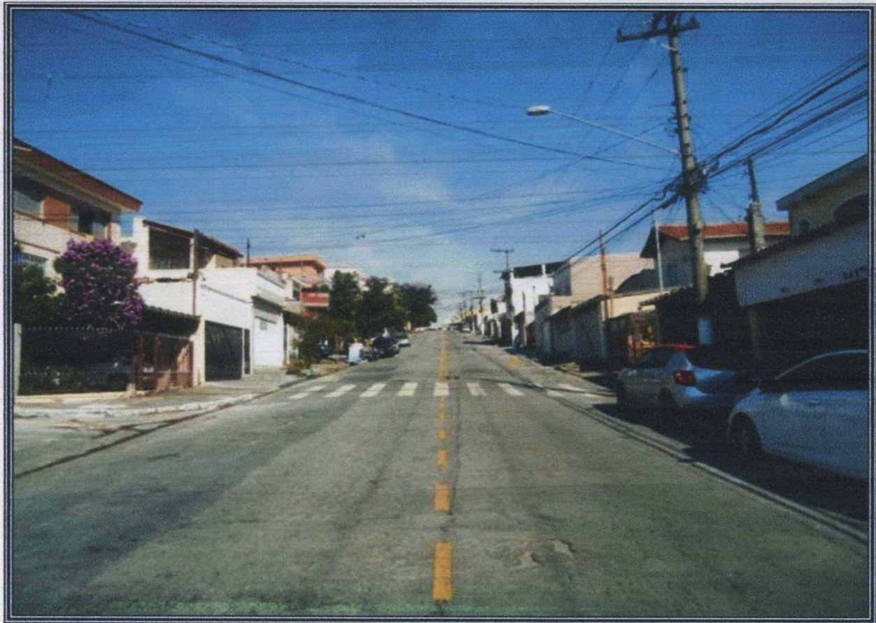
Vista da Rua Anny, que lhe dá acesso.
