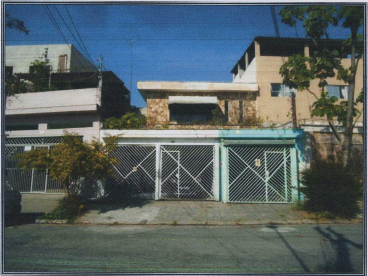
Vista da frente do imóvel avaliando.
