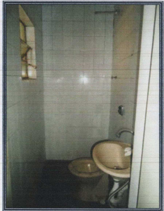
Banheiro da edícula
