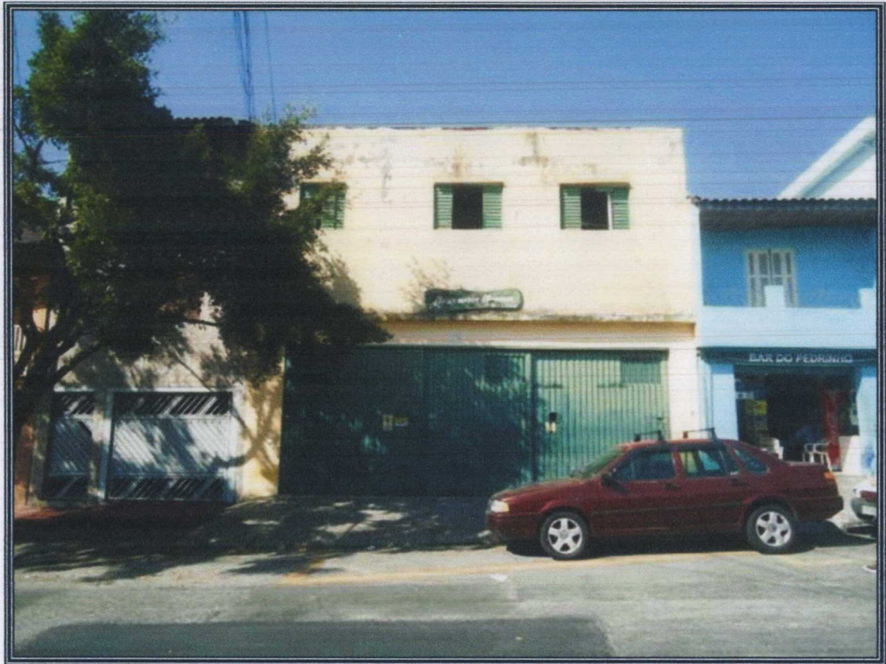
Vista da frente do imóvel avaliando.
